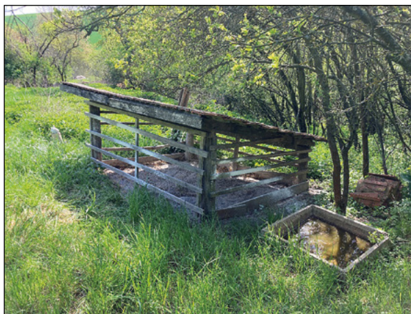
Asanace krmných zařízení
