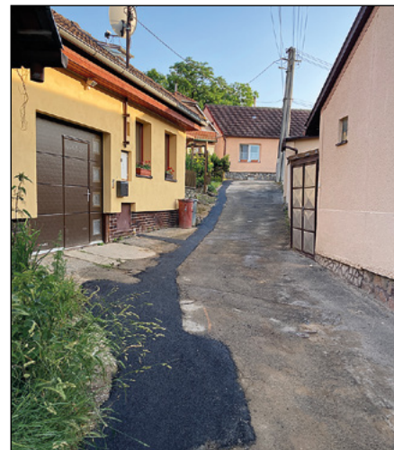
Opravy povrchů místních komunikací.
