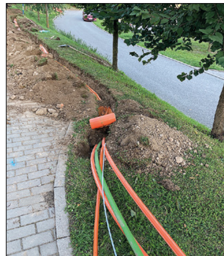
Výstavba datových optických sítí.
