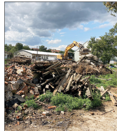
Odstranění staveb v obecním areálu farmy Loučka.
