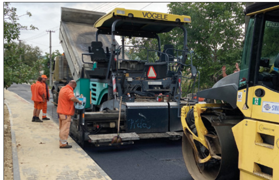
Oprava komunikace v ul. Za Humny
