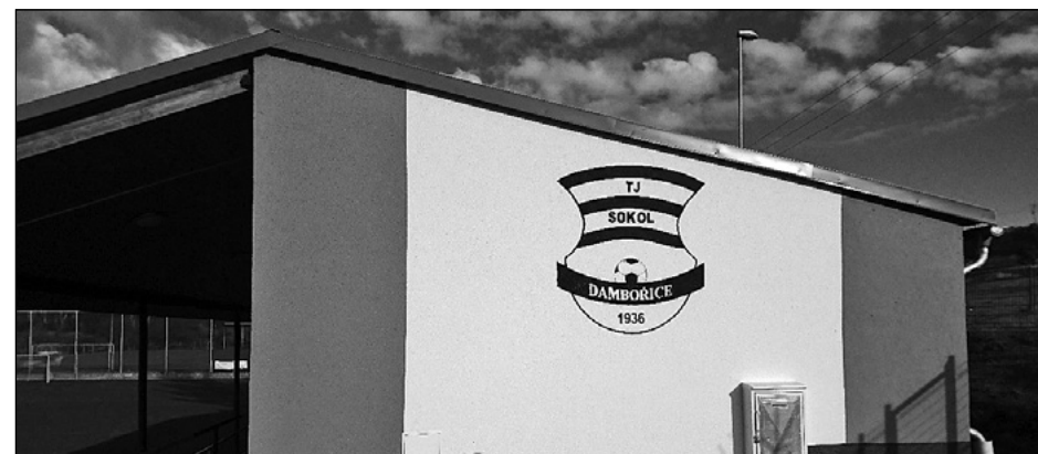
Nová fasáda na kabinách.
