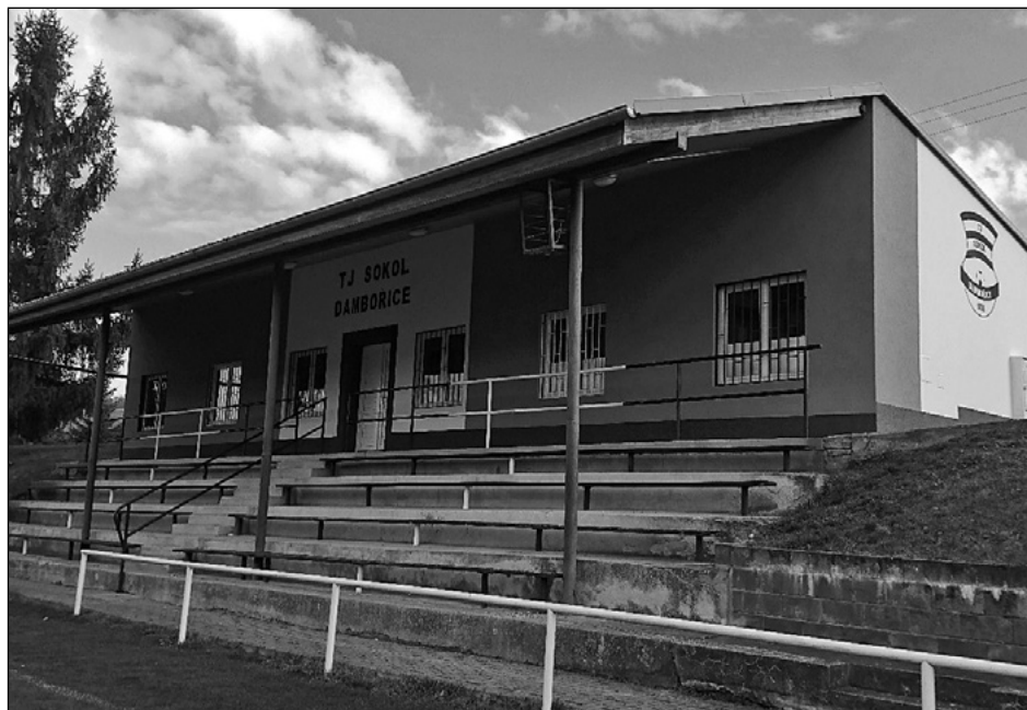
Nová fasáda na kabinách.
