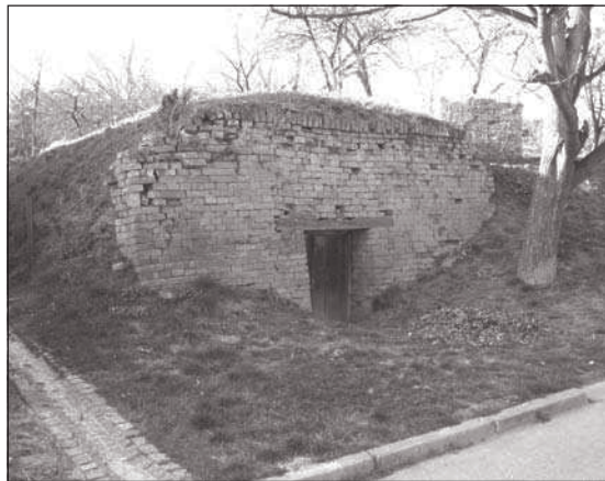
Sklep na parcele st. 516 před opravou
