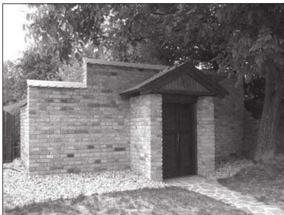
Sklep na parcele st. 516 po opravě
