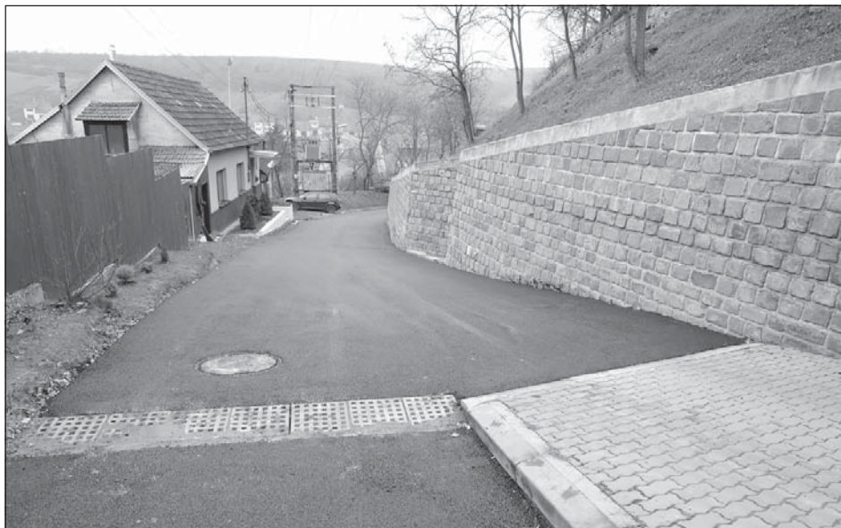
Ulice Šibrov po opravě
