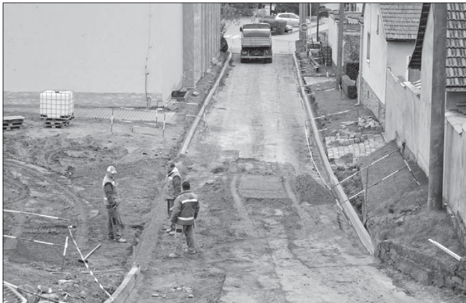
Oprava komunikace u KD
