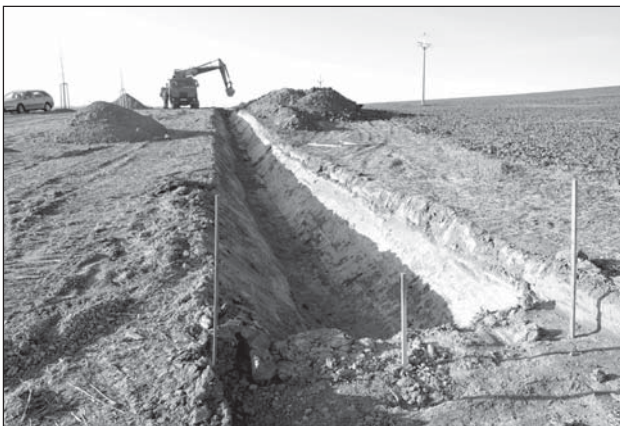
Výstavba záchytného příkopu
