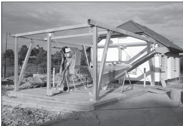
Intenzifikace ČOV (přístavba provozní budovy)
