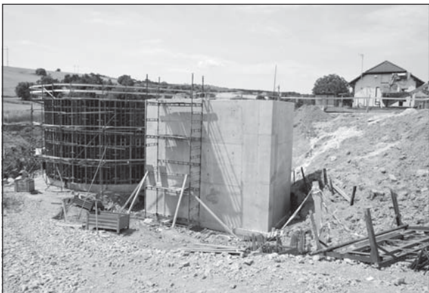
Intenzifikace ČOV (nová část)
