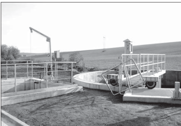
Intenzifikace ČOV (nová část)
