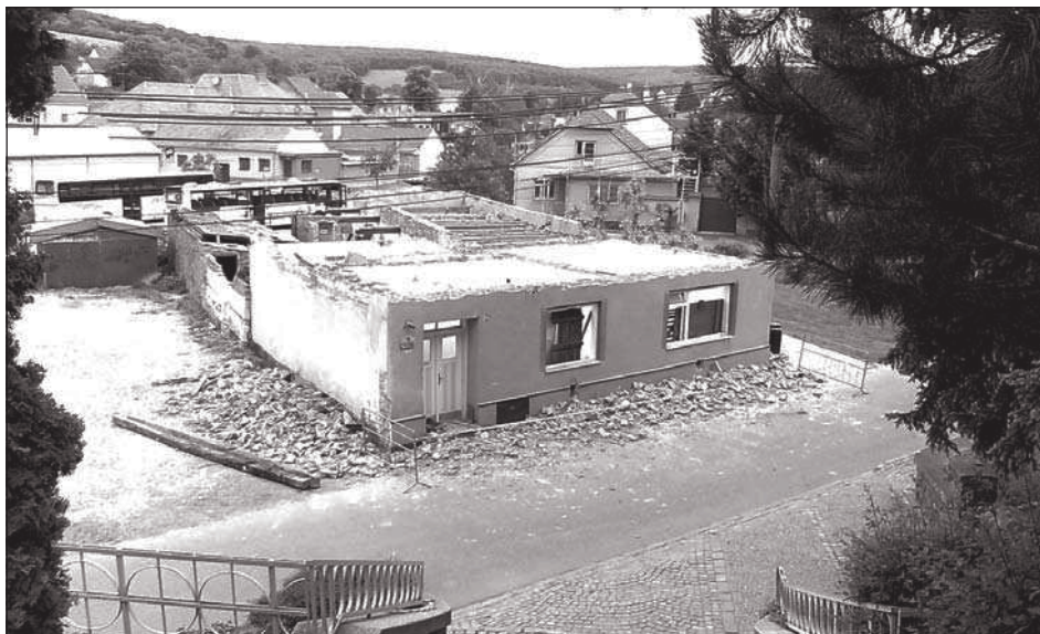
Demolice rodinného domu č. 65
